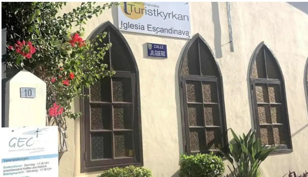
Iglesia evangelica bautista de puerto de la cruz north tenerife international baptist church iglesia evangelica
