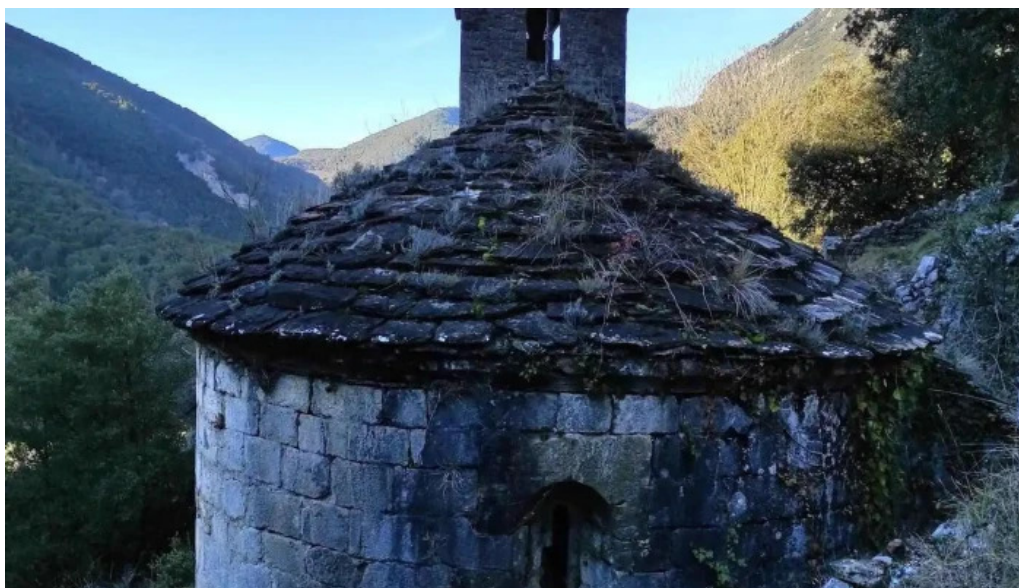
Iglesia de santa maria d escales iglesia
